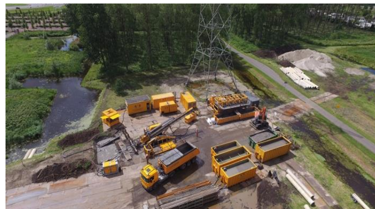
Voorbeeld HDD boring Randstad 380 kV
