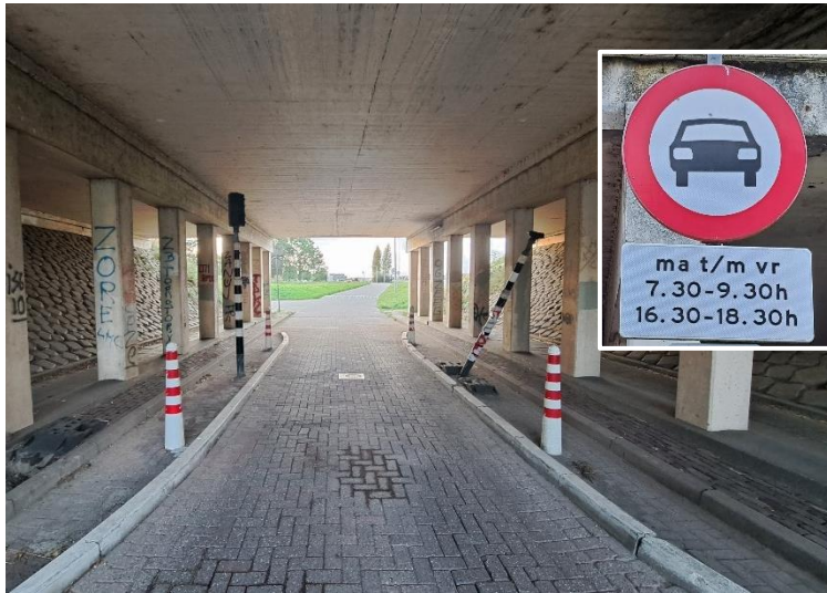
Figuur 2.5 Spitsafsluiting in Almondeweg onder viaduct A44
