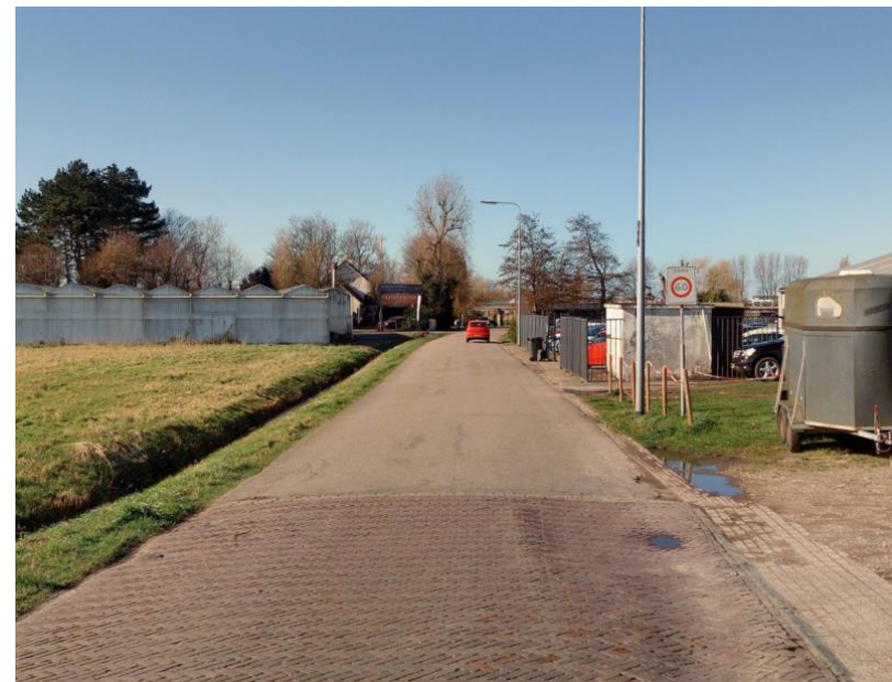
Figuur 7.1: huidige inrichting van de Almondeweg: gemengde rijbaan, asfalt/klinkers, 60 km/u, en zonder voetpaden
