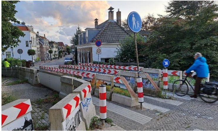
Figuur 2.7 Tijdelijke afsluiting van Dorpsstraat voor autoverkeer
