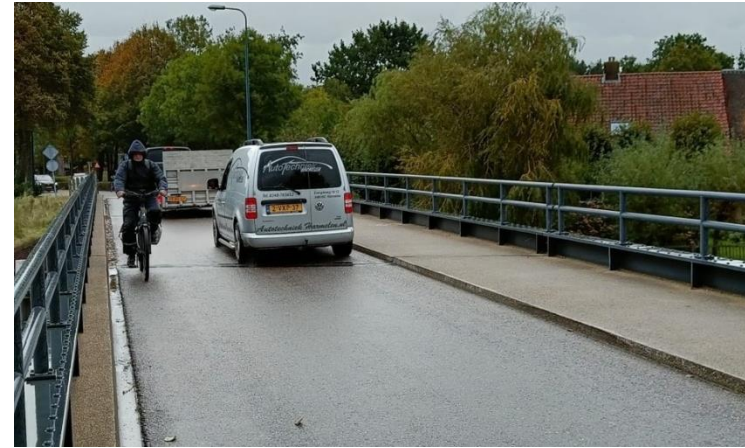
Figuur 2.8 De Van Gerrevinkbrug heeft een beperkte breedte
