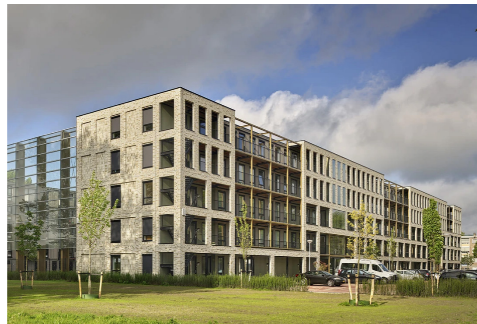
Verzorgde architectuur aan geluidsluwe snelweg (galerij) zijde
