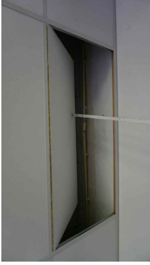
FOTO 2: AFWERKING WAND BRANDCOMPARTIMENT
