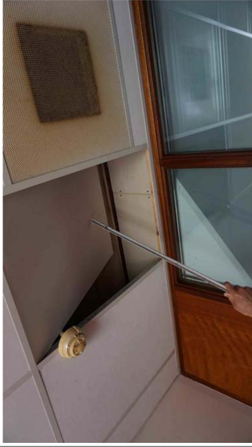
FOTO 3: AFWERKING WAND BRANDCOMPARTIMENT
