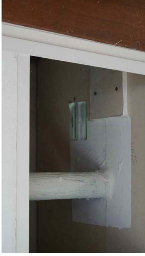
FOTO 4: AFWERKING LEIDING DOOR WAND BRANDCOMPARTIMENT
