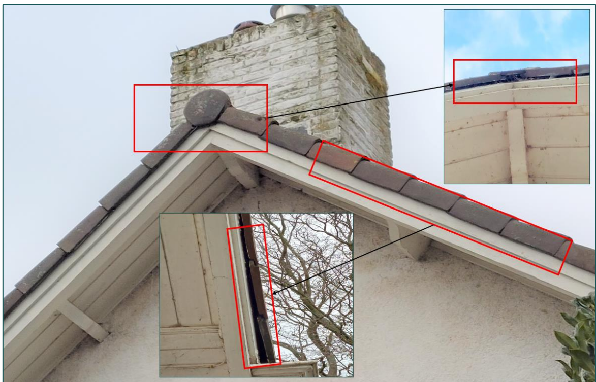
Figuur 3.4 Openingen in de woning (1) tussen kantpannen en nokpan voor vleermuizen.
