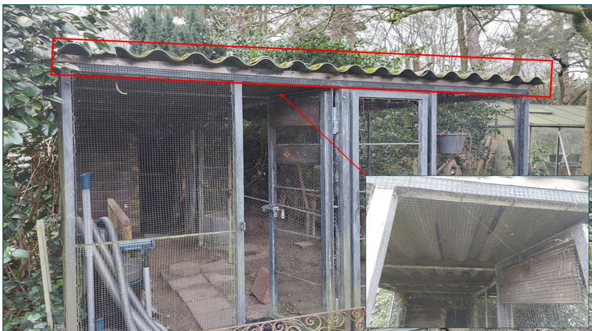
Figuur 3.6 De ruimte tussen golfplaten en het gaas wat geheel onder het dak is bevestigd.
